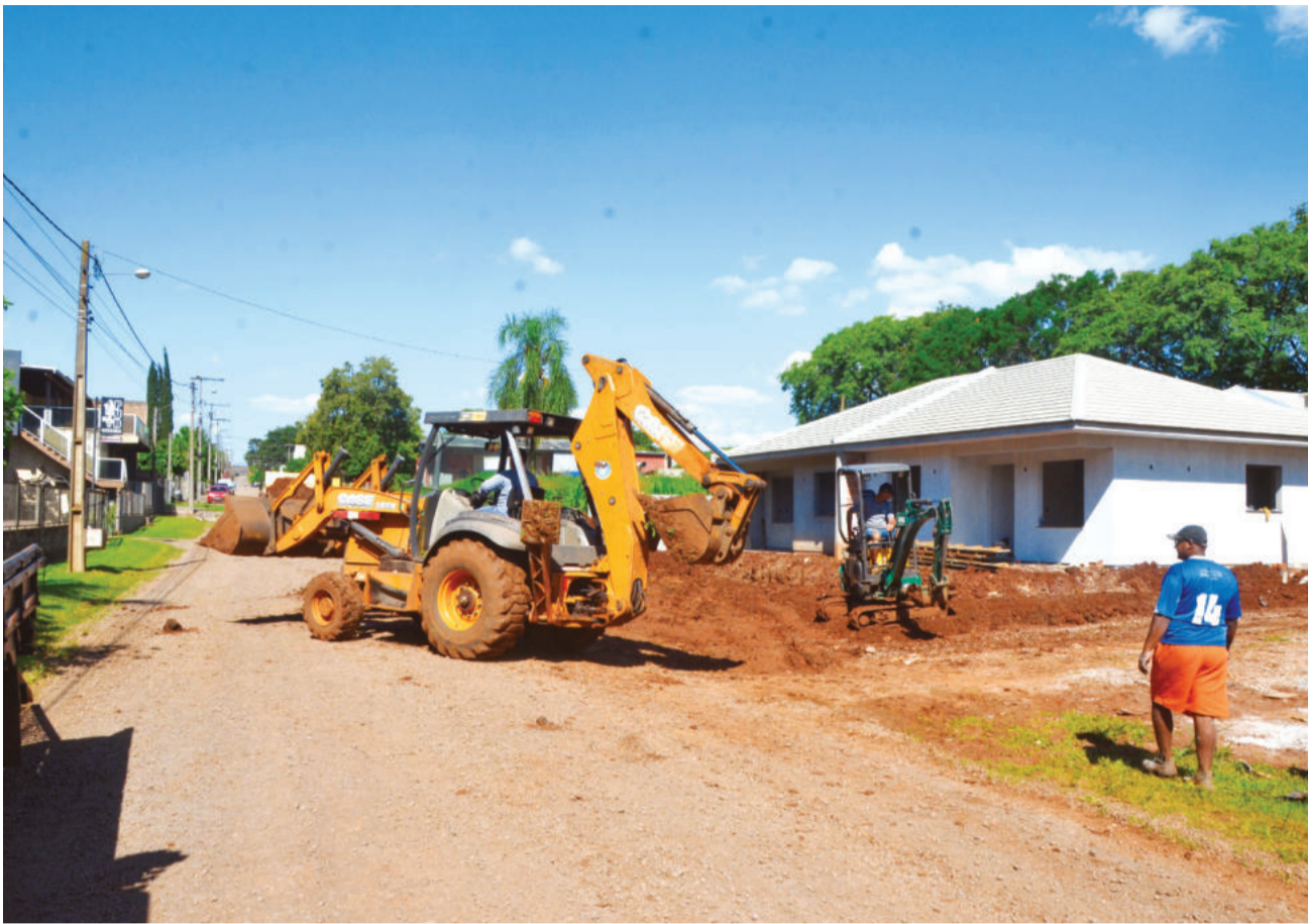
Município, que tinha cinco loteamentos em dezembro de 2025, hoje tem nove em construção
